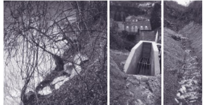
Neuer Auslauf in die Birs, Einlaufbauwerk, offene Rinne
