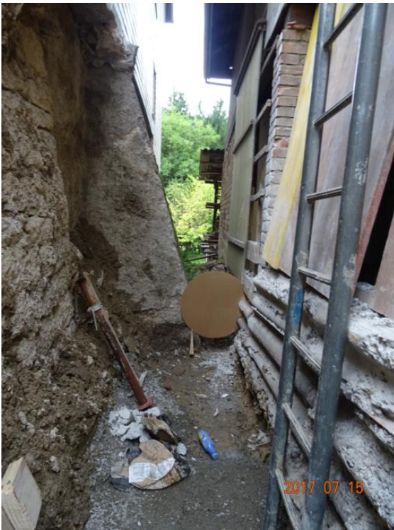
Abb. 5 (340): 150-mm-Pfeiler-/Spornkonflikt bei einem Normrohr D \varnothing 700 mm (Schablone = D 740 mm), Bildmitte links. Bruchsteinsporenstärke = 1300 mm.
