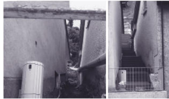
Bausituation vor und nach der Erstellung der Leitung zwischen den Liegenschaften oberhalb der Baselstrasse
