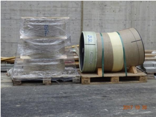
Abb. 42 (192): Freitag, 20.10.2017 spätnachmittags: Die fehlenden Teile für den Lückenschluss sind eingetroffen. (PS: Das Rohrbogenmass (15°) wurde von Franz Maurer ermittelt und an die Fachleute weitergegeben, denn diese wollten etwas ganz anderes bestellen – bzw. hatten schon bestellt. Ein 45°-Bogen war bereits vorhanden/geliefert worden, obschon auf dem Plan kein solcher ersichtlich ist!)
