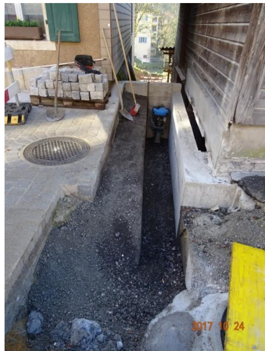
Abb. 45 (198): „Pfeilerstützung in armiertem Beton von oben“. Neue Beton-Aussenwand, direkt auf dem Rohr (bis mittig Rohr gehend). Die Fuge zeigt die Parzellengrenze. Unter Schaufel und Besen: Sockelfundament/Magerbetonmauer.
