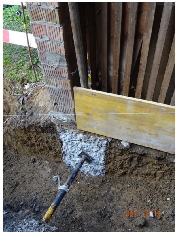
Abb. 39 (1454): Baselstrasse 24a: Ein weiteres Fundament konnte umstandslos bis auf Gebäudeflucht weggespitzt werden ... (Im Nachhinein musste noch der ganze Pfeiler untergraben werden, siehe Abb. 46)
