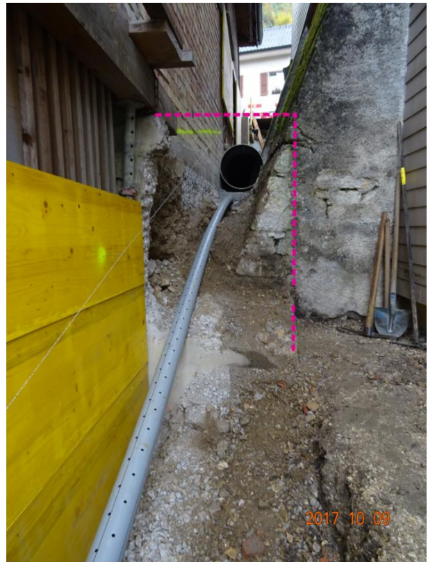
Abb. 37 (1044): Abbruch Stützmauer Gebäude 24a, bis Parzellengrenze (rot markiert), damit das Rohr Platz hat. Im Hintergrund der Stahlrohrkanal. Ende der Fahnenstange (Bauerei) per 03.10.2017 ... vgl. nachfolgend.
