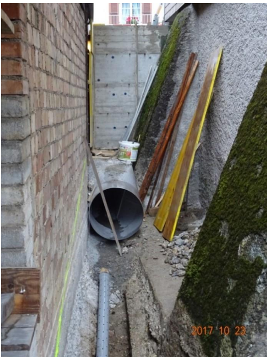
Abb. 44 (195): „Pfeilerstützung in arm. Beton“, die Fuge daran zeigt die Parzellengrenze. Ab Stahlrohrende kam dann die F.-Maurer-Theorie zum Zug. Zum Erstaunen der Fachleute passte diese ... Es wurde nämlich bereits wieder (beim Pfeiler 2, im Vordergrund) nach einem neuen Stahlkanal gerufen ...
