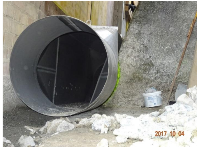
Abb. 35 (1049): Detail Stahlkanal beim Bruchsteinsporn. Grüne Markierung: Nötig gewesene Spornausparung für Normrundrohr = eine Belanglosigkeit.
