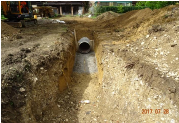
Abb. 9 (557): GFK-Rohr D 700 mm. Situation im Garten, 28.07.2017, Parzelle 507.
