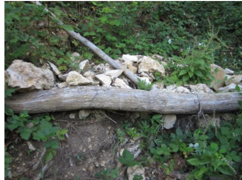
Abb. 43: Situation anfangs Nov. 2017, nach der Felsbachgrabenreinigung: Eine neue Geröllmengenbombe ist am Entstehen (unterhalb der grossen Felsstufe, K (m): 2'611'526, 1'254'755), im Bild sind noch die Ablagerungen des sog. Murgangs vom 08.06.2016 (als das Wasser weniger wurde) zu sehen.
