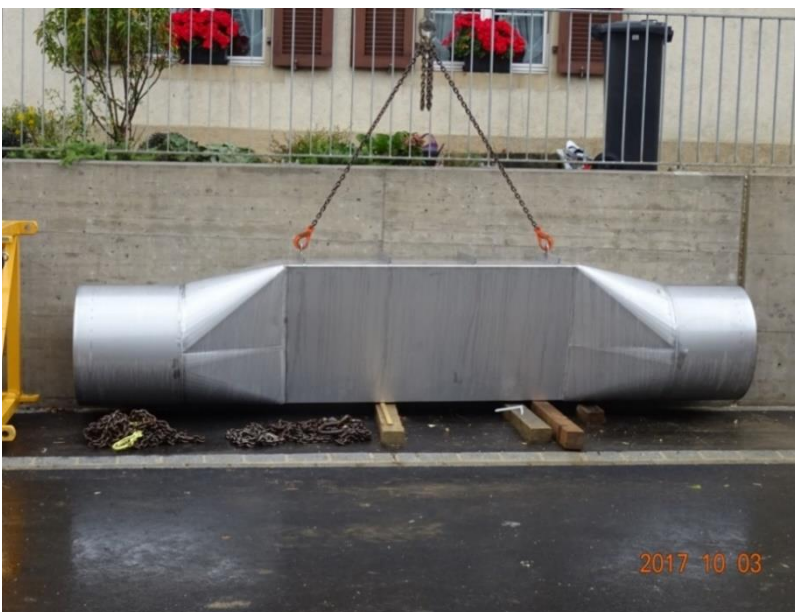
Abb. 33 (1032): 03.10.2017: Das Auflager ist betoniert (ist betoniert richtig?), der Kanal wird eingefügt.
