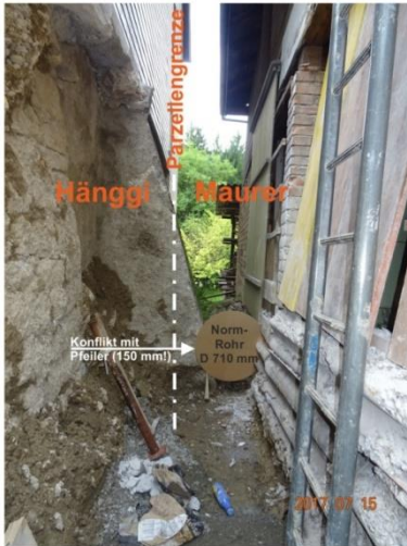
Abb. 102: Bauverzögerung wegen des kleinen Konfliktes (Bagatelle), der Nachbar gibt keine Einwilligung zum Anschneiden seines Pfeilers, der notabene noch auf unserem Grund steht. Dass man nicht vorher miteinander reden kann ... und jetzt ist der Nachbar 3 Wochen in den Ferien ...
