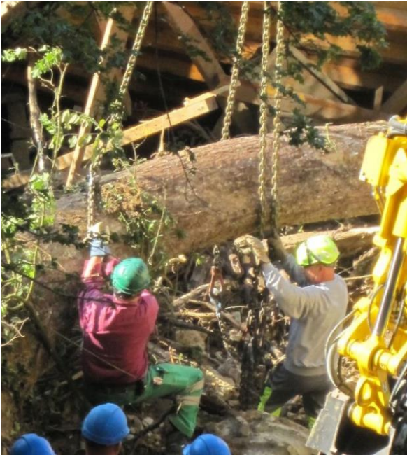
Abb. 52: Wegschaffen der Gerölllawine-Ablagerungen vom 08.06.2016. Ort: Unmittelbar nach dem jetzt gebauten Einlaufbauwerk 2, wo die Rinne flacher wird. Ohne grosse Kräne und Bagger war da nichts zu auszurichten.
