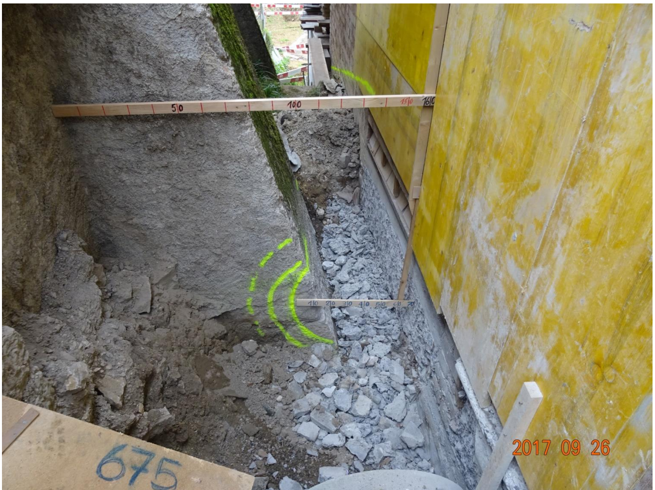
Abb. 24 (990): Situation per 26.09.2017 bei der 1.66-m-Enge (Schnitt C – C auf Ingenieurplan, Abb. 4, mit 1.75 m vermasst, was nicht stimmt! ), bereinigte rechte Gebäudefassadenflucht bis linke Gebäudefassadenflucht. ... bald ist alles bereit für den Stahlkanaleinbau.
