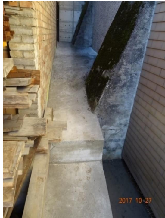
Abb. 47 (214): Das Rohr ist eingebaut und alles ist zubetoniert, die Pfeiler sind ebenfalls im Beton. Realistisch gesehen haben jetzt die Bruchsteinsporen im unteren Teil keine Funktion mehr, sind sie doch voll mit Beton ummantelt. Die Mauerkante und die Trennfuge an der Betonwand (hinten) markieren die Parzellengrenze. Das Rohr und der Stahlkanal liegen voll auf dem Grund der Parzelle 507.
