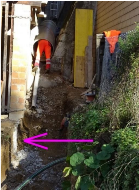
Abb. 46 (199): Franz (Baselstr. 24a) Grösse zeigen: © Gemeinderat Hans Raithofer. Hier ist von der Pfeilerstärke von 250 mm nicht mehr viel übrig, Machart wegen der bereits erfolgten Fehlverlegung der Leitung weiter talwärts (Anschluss) . Rechts vom Strich mit Pfeil (Eisenbahnschwelle) ist die Parzellengrenze. Im Sinne der Gleichbehandlung aller wäre hier (wo der Mann steckt bis Pfeil) auch ein Stahlkanal fällig gewesen. „Die Baselstrasse 24 gibt alles. Damit die Baselstrasse 41 & 43 nicht alles verlieren“.
